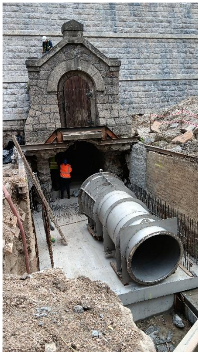
Obr. 9 Montáž segmentu spodní výpusti DN1200
