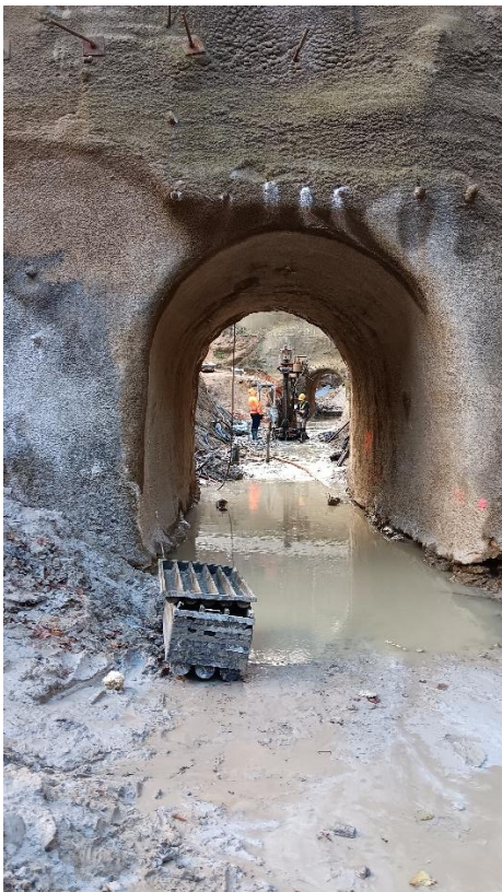
Obr. 4 a 5 Podražba spodních výpustí. Obr. 6 betonáž hloubené části štol
