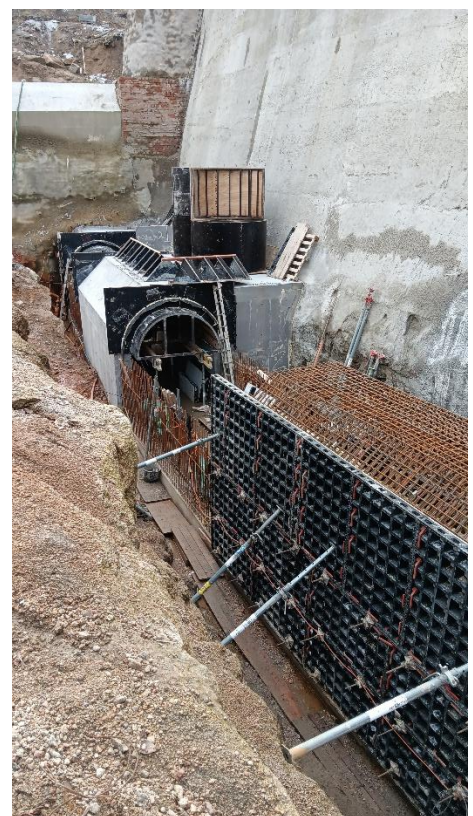
Obr. 4 a 5 Podražba spodních výpustí. Obr. 6 betonáž hloubené části štol
