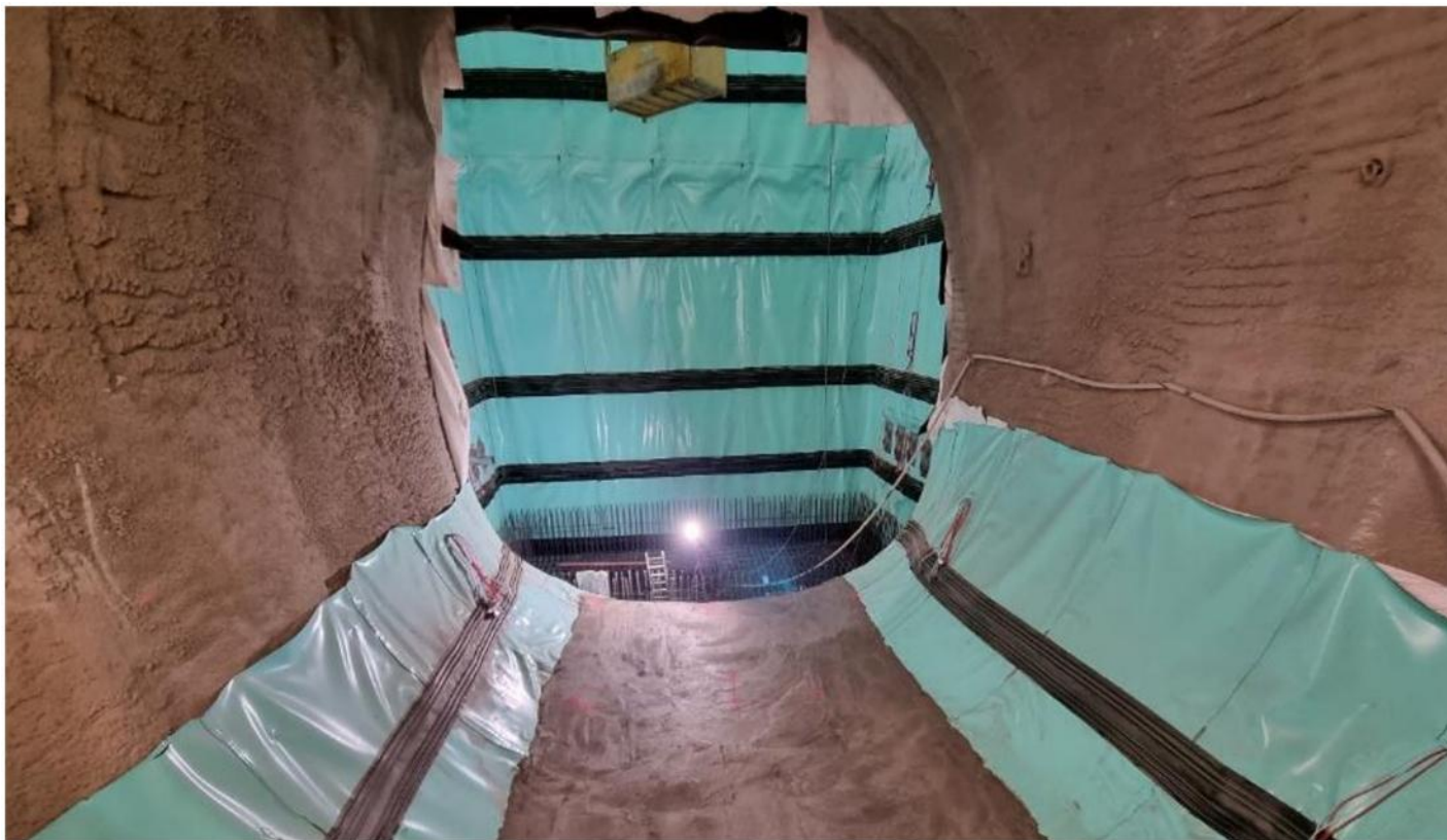
Obrázek 7: Hydroizolační systém dna s ochrannou vrstvou betonu
