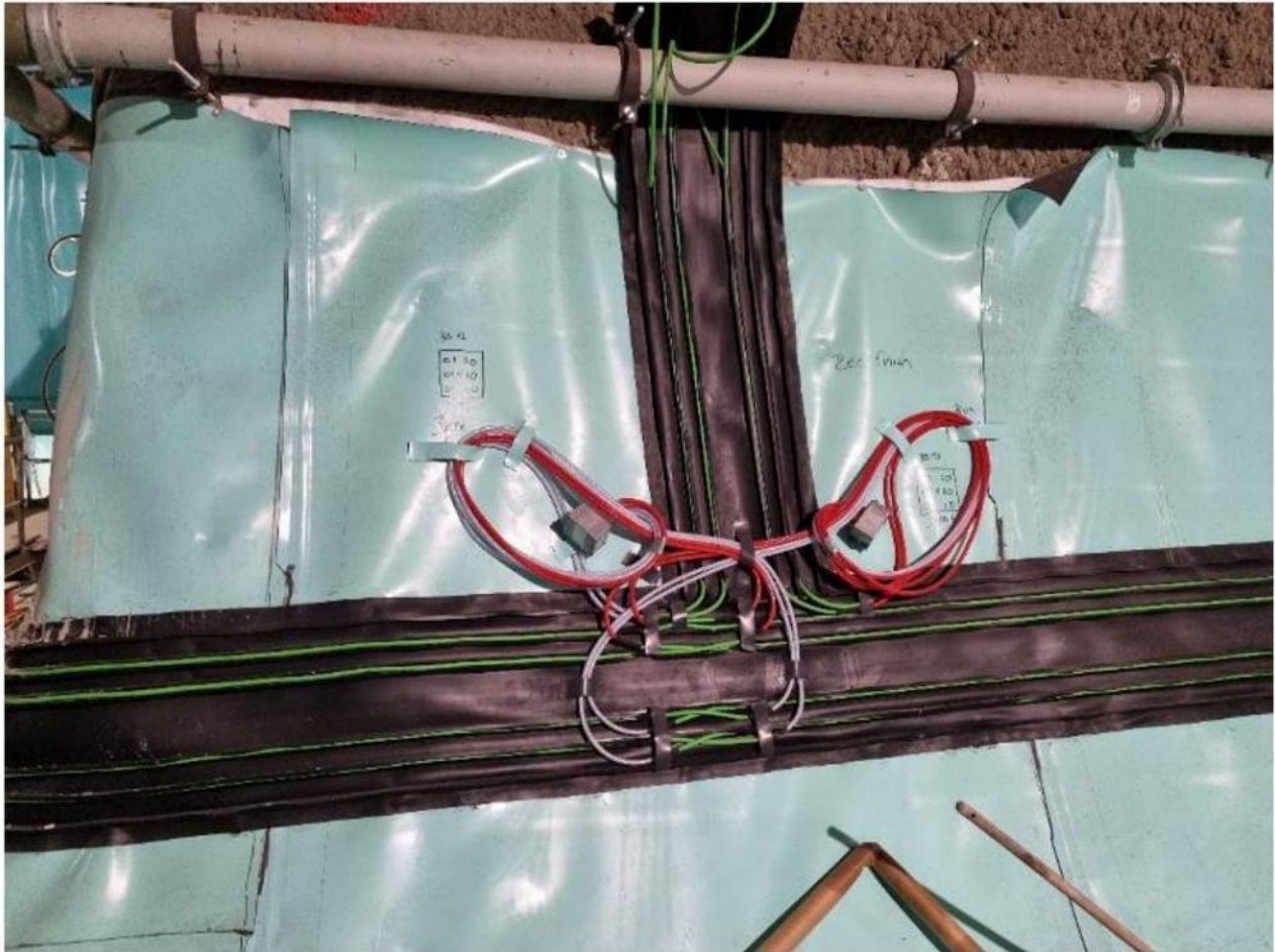
Obrázek 8: Vnější spárový pás s injekčními hadičkami
