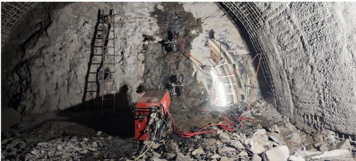
Obrázek 4: Rozřezávání železobetonové čelní stěny pomocí diamantového lana
