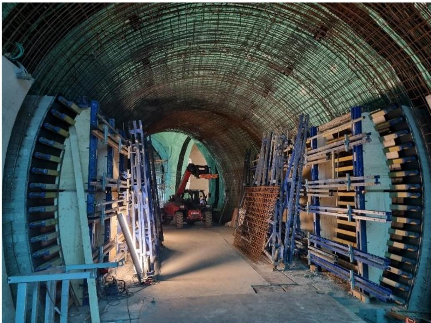
Obrázek 10: Bednicí prvky pro sekundární ostění
