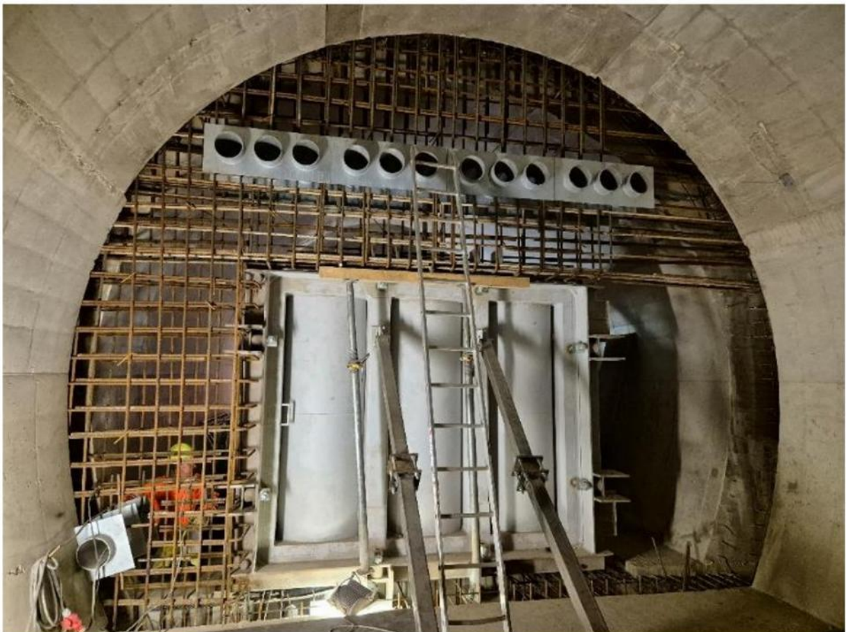
Obrázek 9: Příprava betonáže tlakového uzávěru
