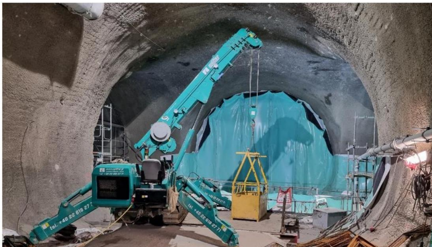
Obrázek 6: Speciální zdvihací prostředky pro obsluhu šachet
