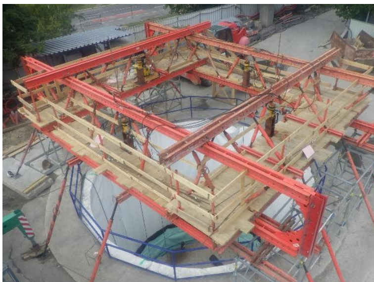
Obrázek 2 - Realizace větrací šachty
