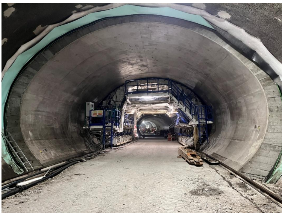
Obrázek 11 - Betonáž pomocí ocelové hydraulické formy dvoukolejného tunelu
