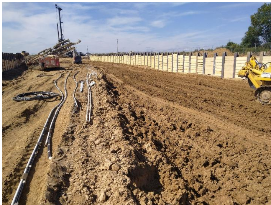
Obrázek 4: Záporové paženie v počiatočnej fáze výstavby
