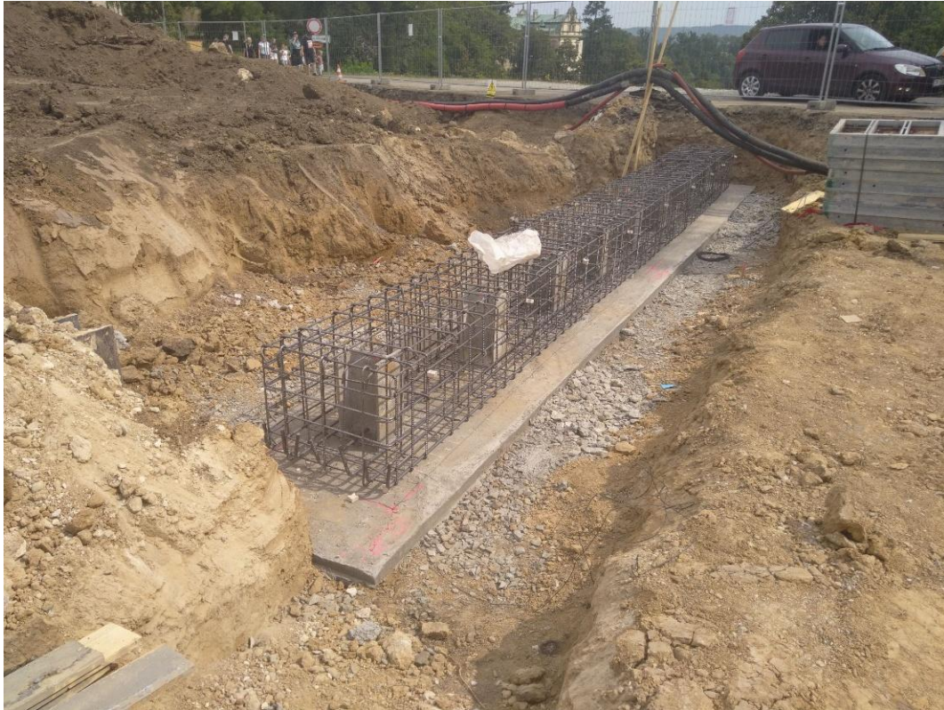
Obrázek 5: Založenie mostného provizória vo fáze realizácie
