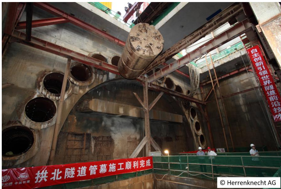
Obrázek 7: Realizace pipe-roofingu pomocí AVN 1200 na silničním tunelu Gongbeiv Číně (archiv Herrenknecht AG)
