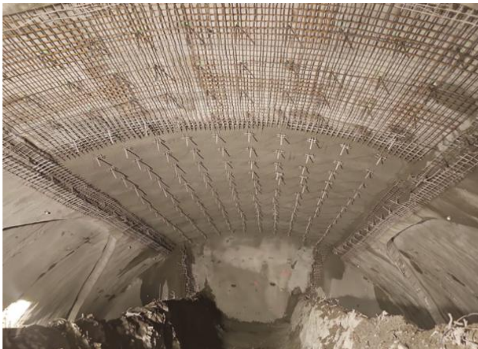
Obrázek 10: Zesílené ostění stanice
