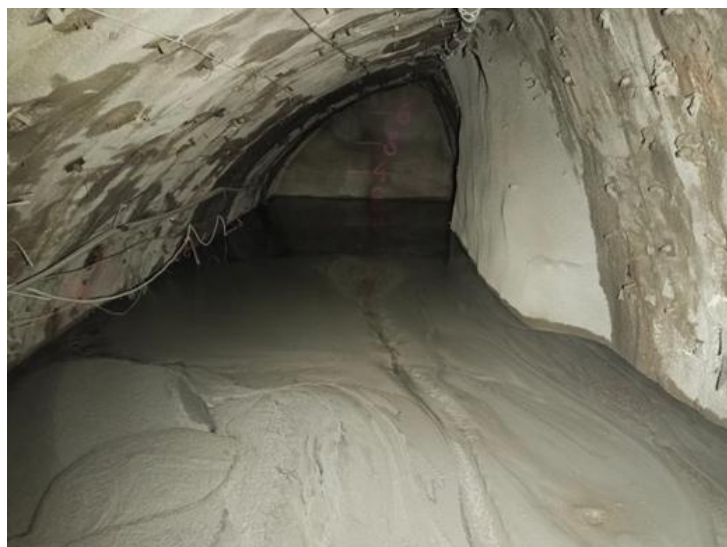
Obrázek 8: Zalívání části přestupu výplňovým betonem TERRAFLOW
