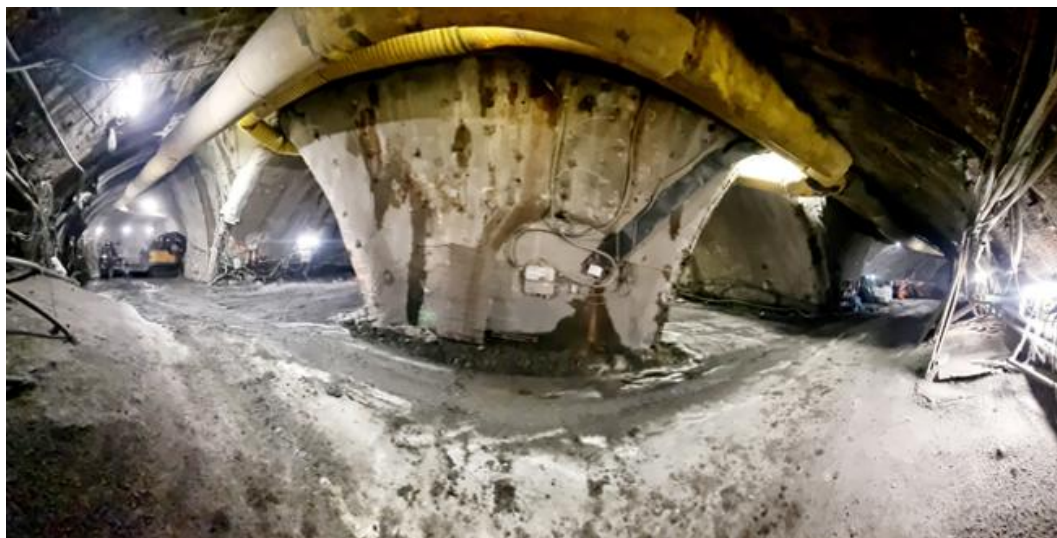
Obrázek 5: Ražby kalot bočních výrubů
