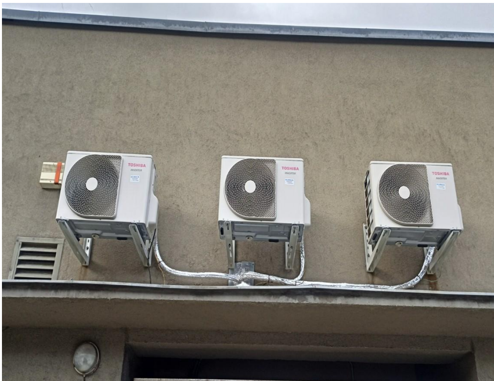
Obrázek 14: Nově osazené chlazení PTO
