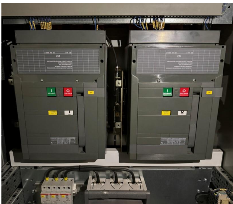
Obrázek 7: Výkonové jističe (deony) ve výsuvném provedení
