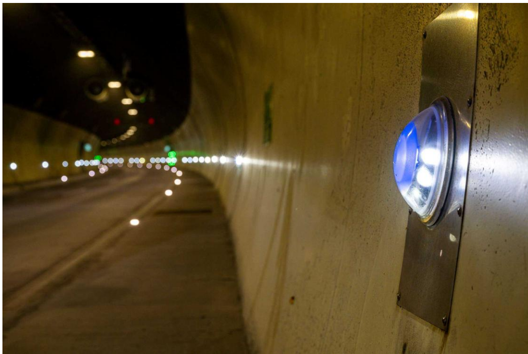
Obrázek 4: Svítidlo nouzového osvětlení s poziční modrou LED diodou
