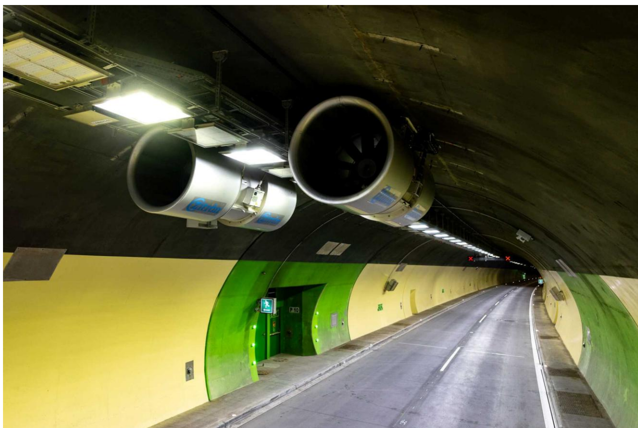
Obrázek 11: Nově osazené proudové ventilátory ZITRON
