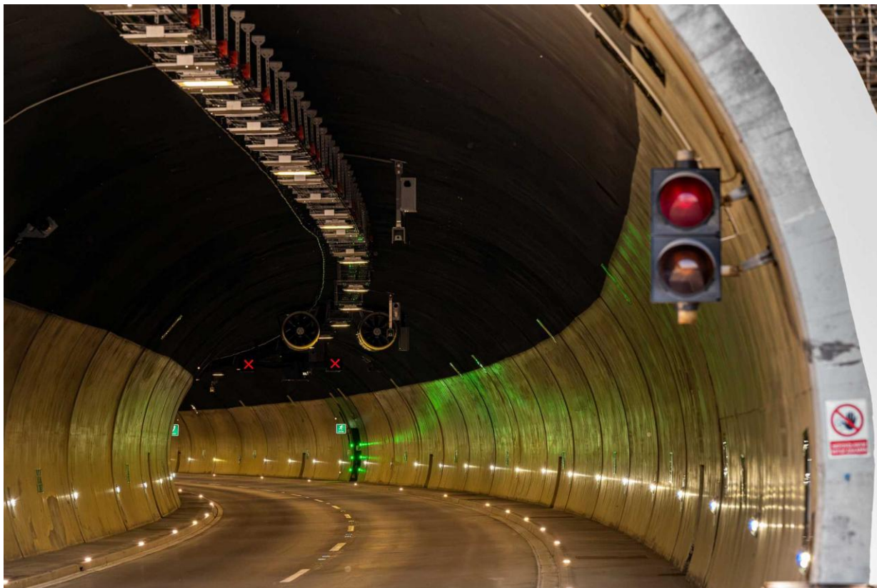
Obrázek 6: Tunelová trouba s indukčním vodícím osvětlením
