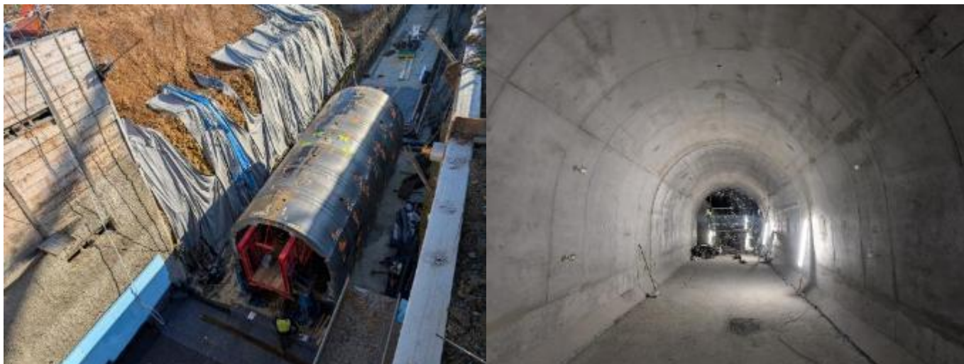
Obrázek 20 Bednicí forma horní klenby (vlevo), dokončené bloky sekundárního ostění (vpravo)
