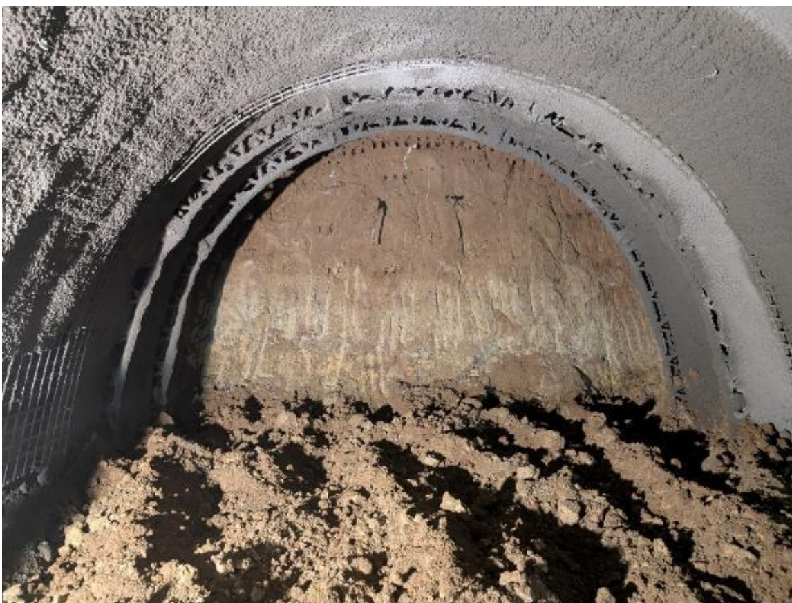
Obrázek 11 Čelba kaloty tvořená jílovitou zeminou s písčitou příměsí (TM 264)
