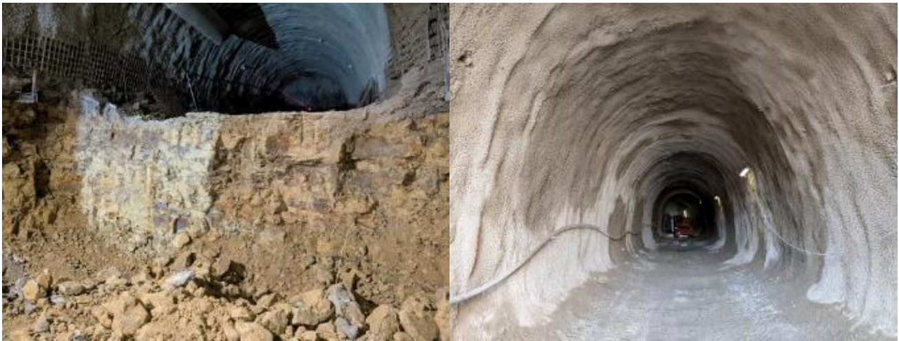
Obrázek 12 Čelba jádra (vlevo), dokončený úsek primárního ostění po profilaci (vpravo)
