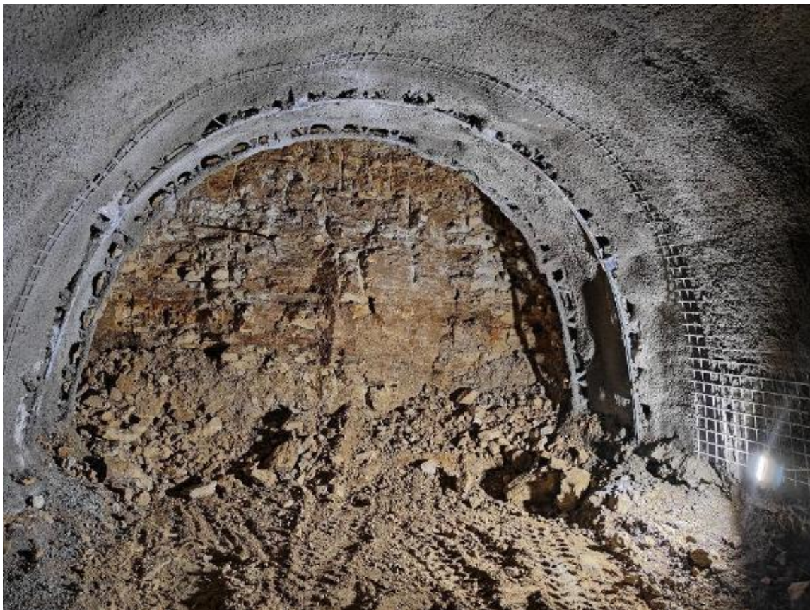
Obrázek 10 Čelba kaloty tvořená mírně zvětralým slínovcem písčtým s deskovitou odlučností (TM 66)
