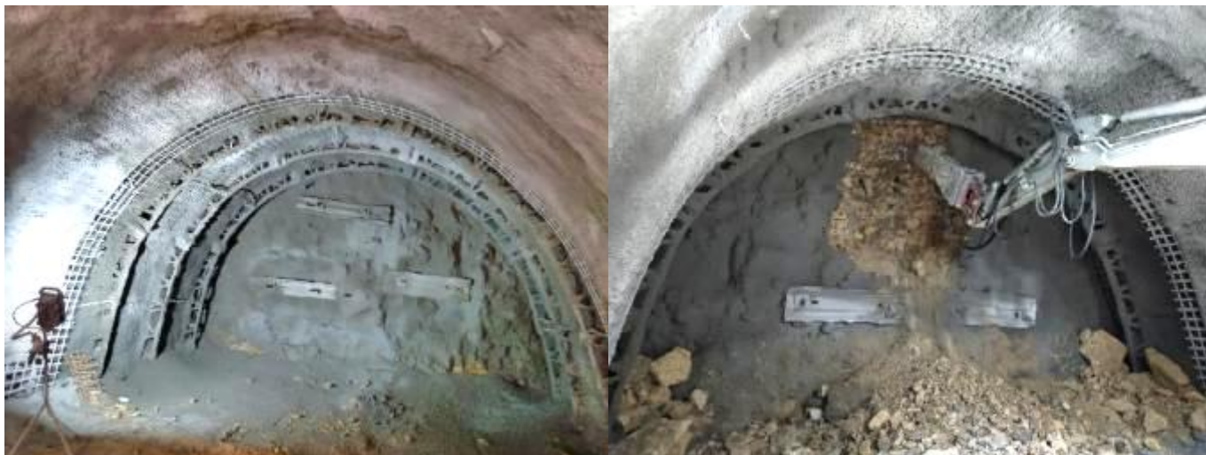
Obrázek 8 Zajištění čelby kaloty a její rozpojování po částech v úvodním úseku ražby
