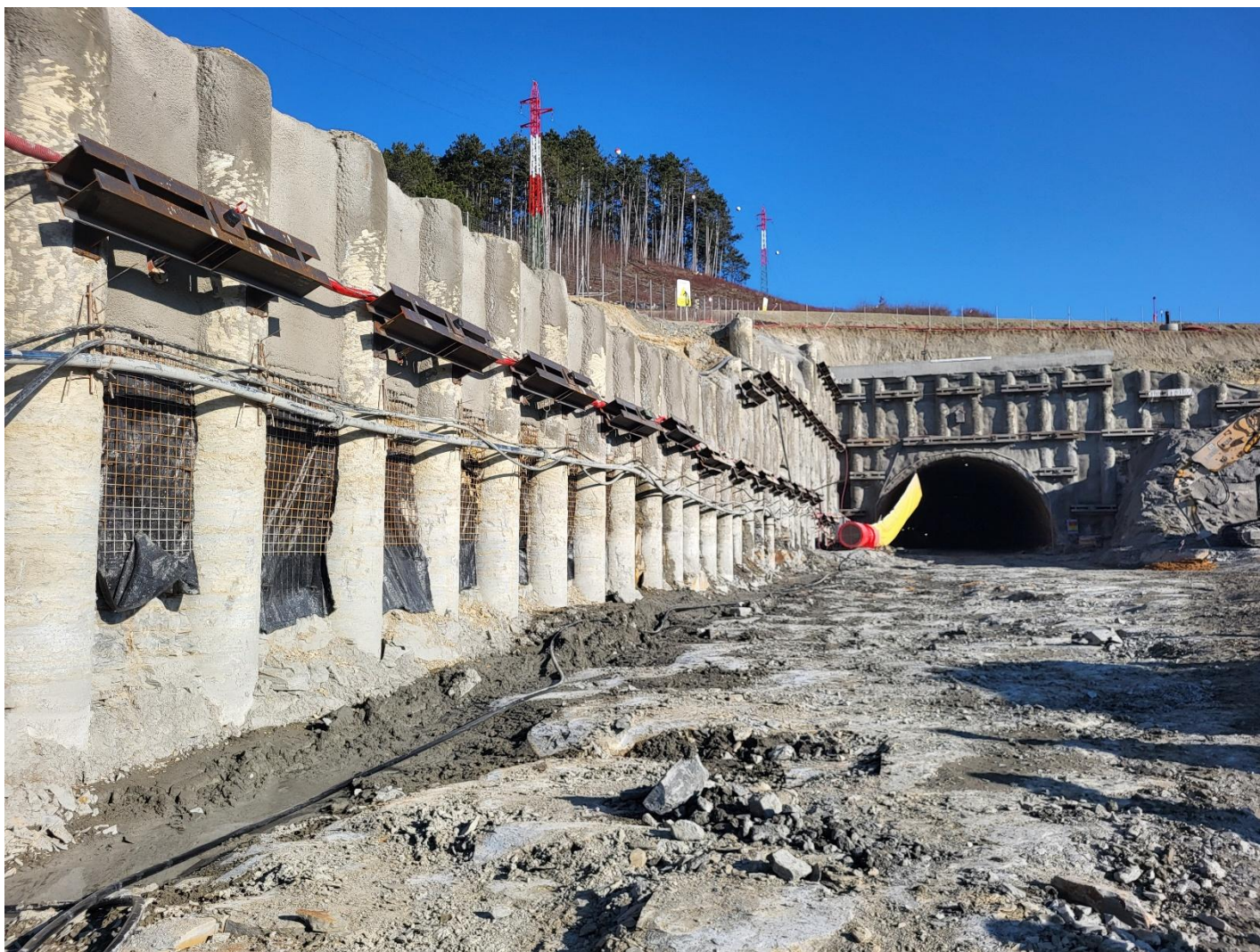
Obrázek 2: Zajišťování stavební jámy na západním portále
