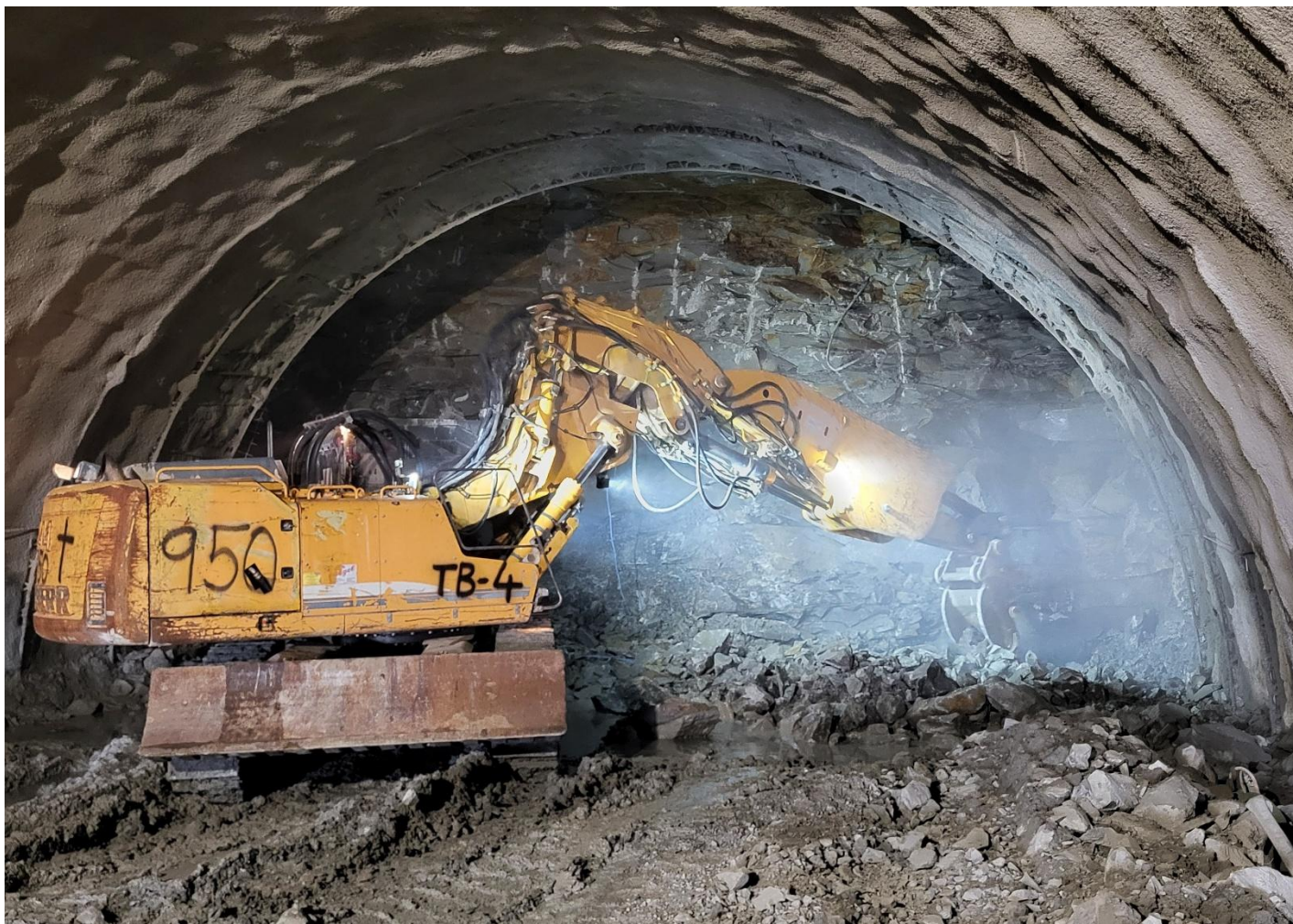
Obrázek 3: Rozpojování horniny v LTT
