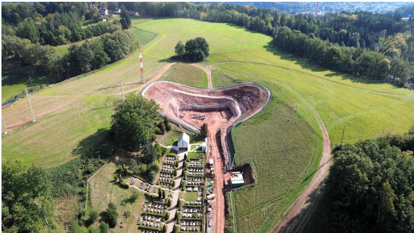
Obrázok 9: Pohľad na stavebnú jamu – stredný úsek
