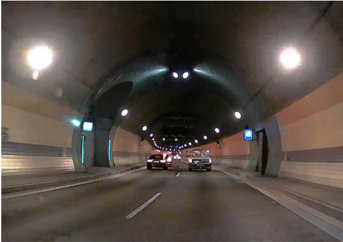
Obrázek 7: Ukázka instalace dynamických pruhových svítidel zelené barvy v TKB
