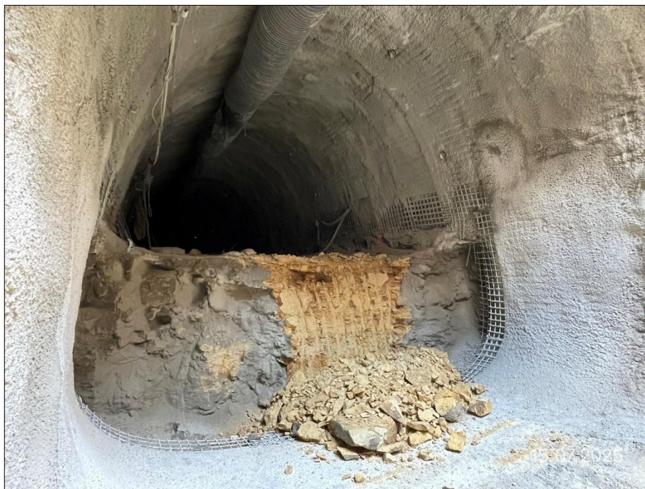
Obrázek 7: ražba opěrky kolektorového tunelu ze šachty Š8 k technické komoře TK7; (foto autora)
