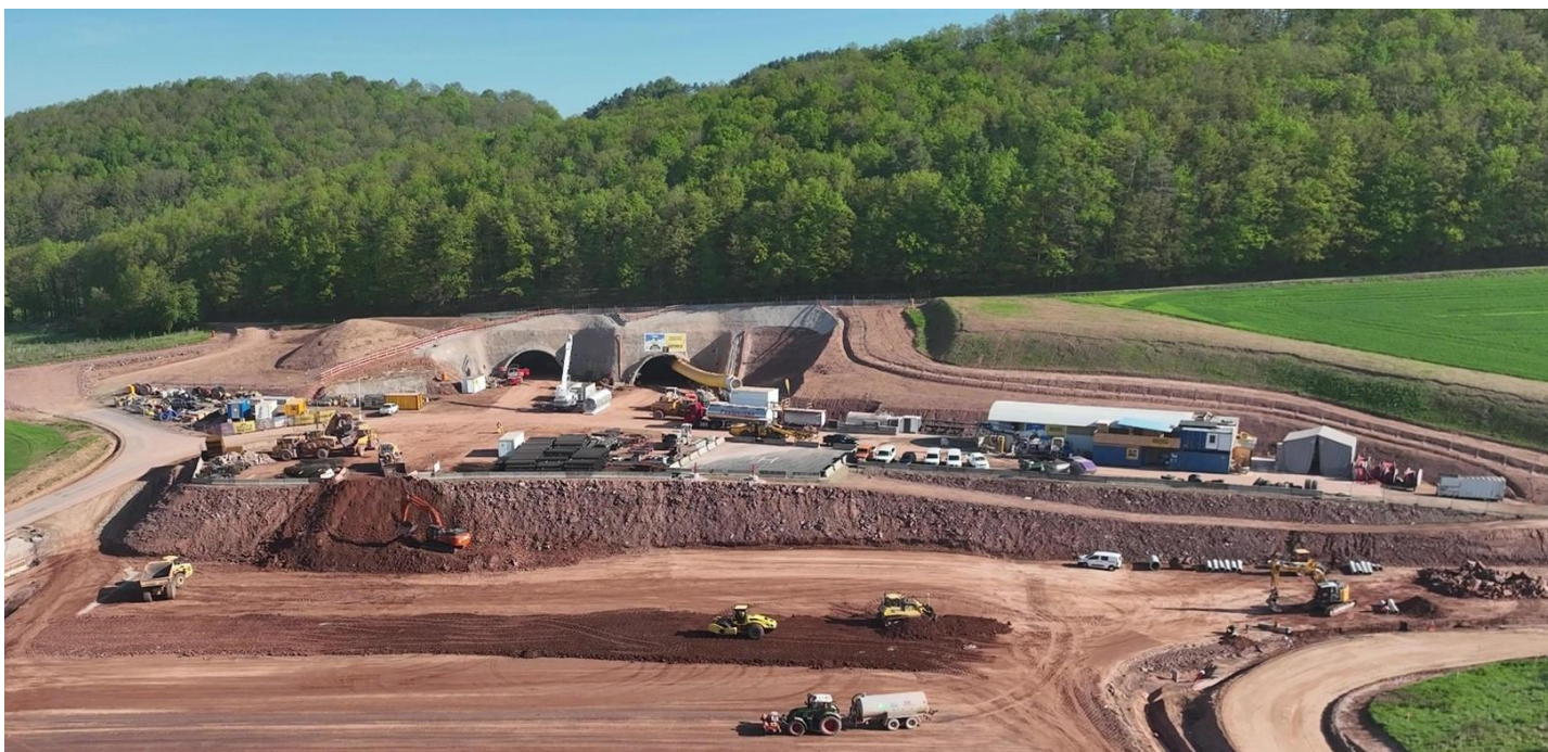
Obrázek 6: Jižní portál včetně zařízení staveniště.
