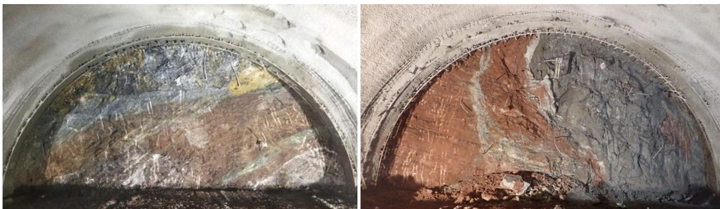
Obrázek 4: Čelba kaloty VTT v TM 1051 TM, Obrázek 5: Čelba kaloty VTT v TM 455.
