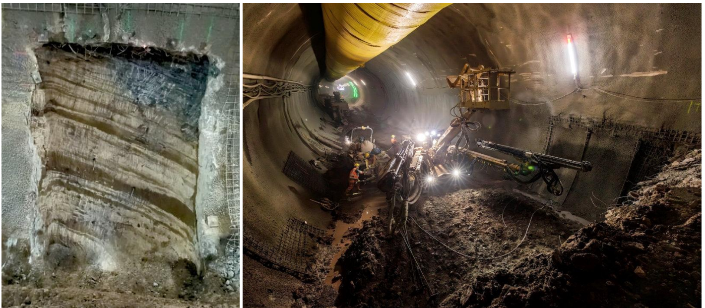
Obrázek 12: Ražba výklenku na rozhraní oblasti Zechstienu, Obrázek 13: Ražba opěří v oblasti propojky.
