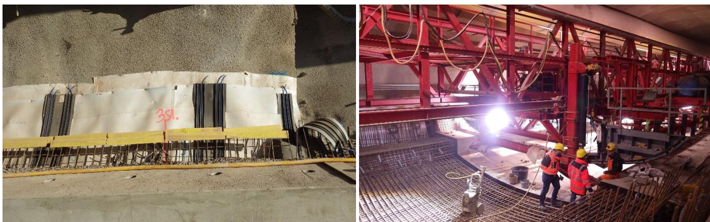
Obrázek 15: Těsnící pásy na rozhraní ražené a hloubené části, Obrázek 16: Betonáž dna.
