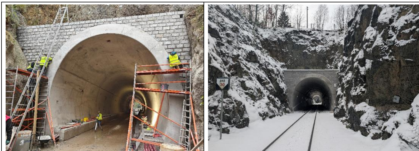
Obr. 15 Obklad nového portálu přírodním kamenem a zasazení tunelu do krajiny
