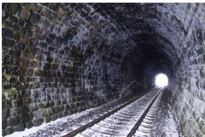
Obrázek 3 Stav obezdívky v suchém období
