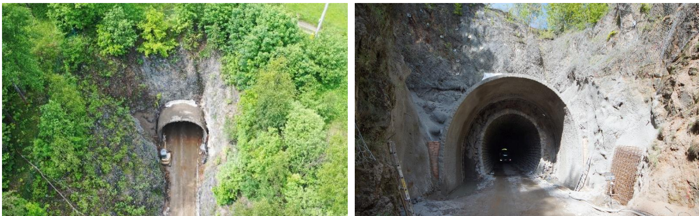
Obr. 16 Stísněné prostorové podmínky tunelového portálu v hlubokém skalním zářezu
