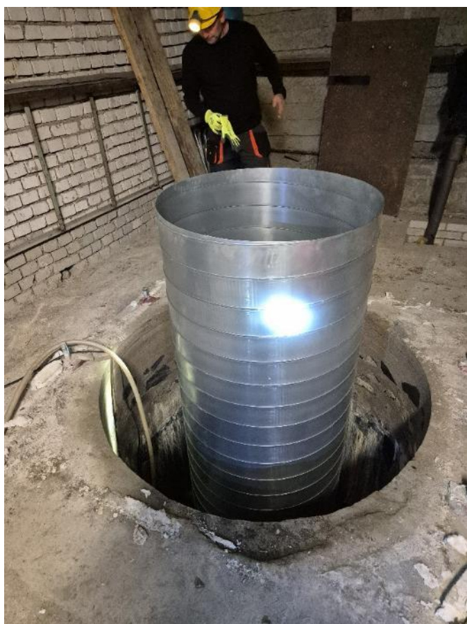
Obrázek 3 – Vlevo je zkušba velkoprofilového vrtání v podzemí (průměr vrtu 1650 mm a hloubka okolo 2000 mm) pro projekt MATEO s trubkou která naznačuje svislé uložení kontejneru s vyhořelým jaderným palivem a vpravo je 3D koncepční návrh experimentu projektu MATEO (zelené úzké vrty označují monitoring horniny, tmavě šedivou je betonové plato na počvě a červeně je označeno topné těleso, které bude simulovat uložení vyhořelého jaderného paliva ve vrtu o průměru 1650 mm (světle šedivá) a hloubce 5300 mm.
