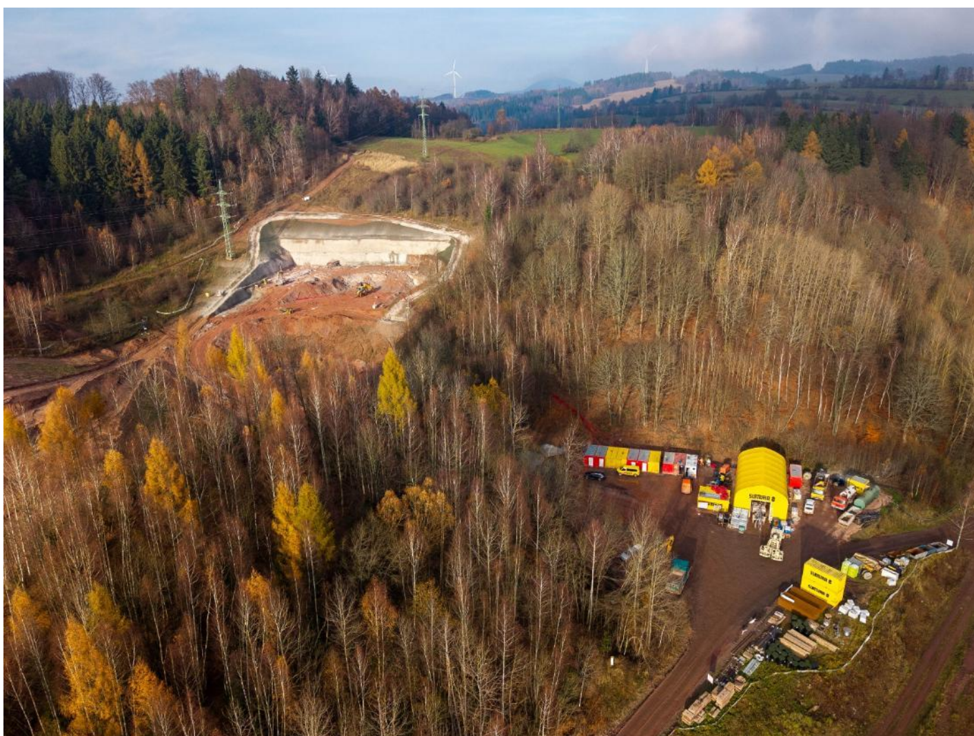
Obrázek 3: Zařízení staveniště v blízkosti jižního portálu tunelu Opevnění
