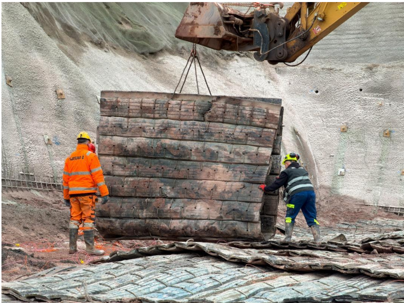
Obrázek 6: Použití ochranných rohoží jako opatření při trhačích pracích
