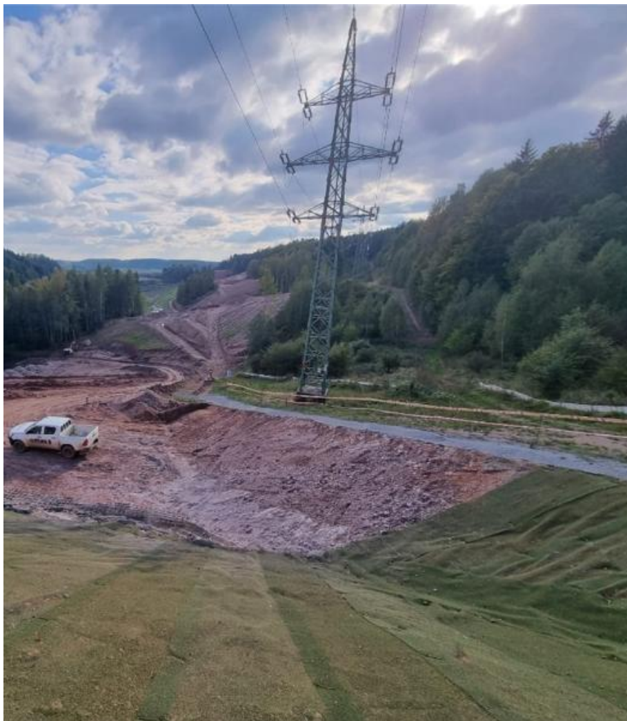
Obrázek 5: Pohled na stožár VVN z koruny svahu výkopu
