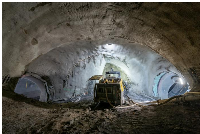
Obrázek 6: vrtání čelových kotev v technologickém tunelu propojky jih stanice
