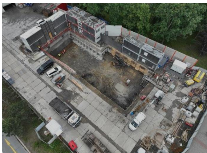
Obrázek 10: pohled z dronu do jámy severního vestibulu se zvukově pohltivým obkladem na protihlukových bariérách při injektování mikropilotového deštníku eskalátorového tunelu sever
