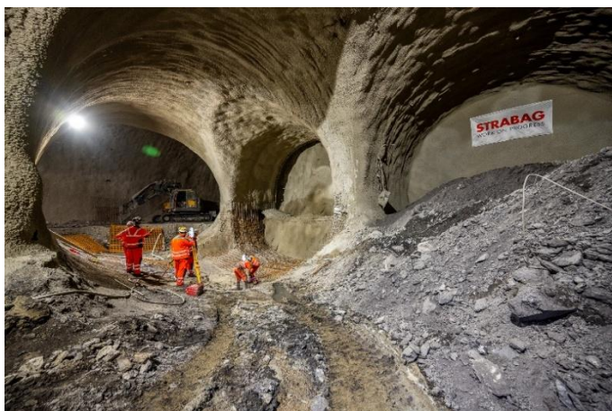
Obrázek 5: geodetické zaměřování příhradových rámu ve dně
