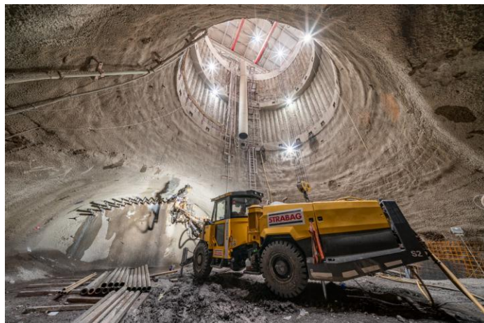
Obrázek 4: rozrážka propojky sever ze šachty pro výstavbu stanice
