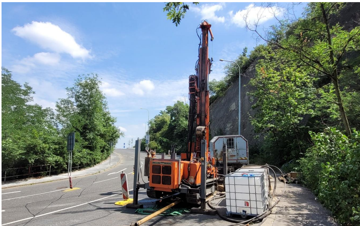
Obrázek 4: Realizace průzkumného vrtu J1 v serpentýnách Barrandovské ulice v Praze (červen 2024).
