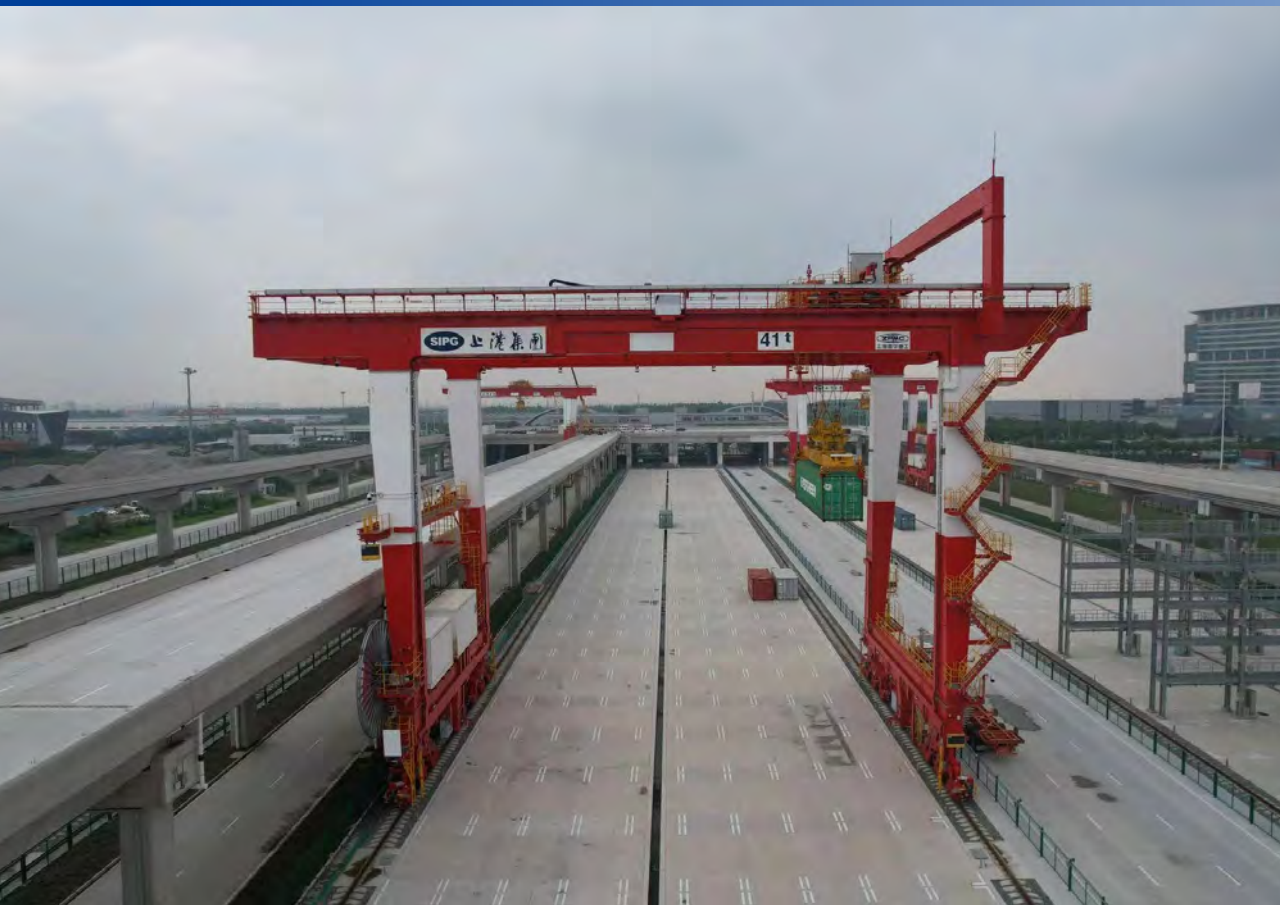
洋山港水公铁集疏运中心 (全自动化轨道吊+自动驾驶智能集卡双层作业工艺)
