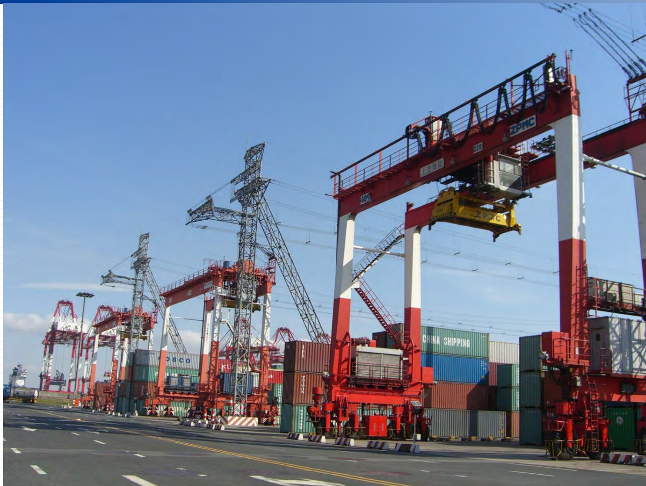
高空跨箱区滑触线
