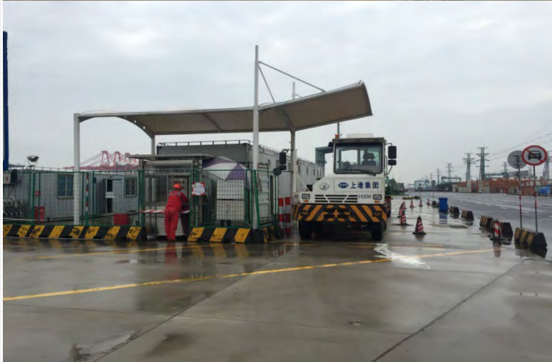
▲ LNG filling station in the port area
