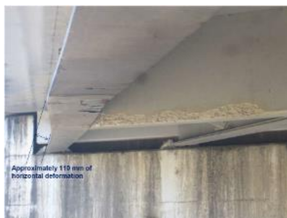
(d) Deformed steel girder
